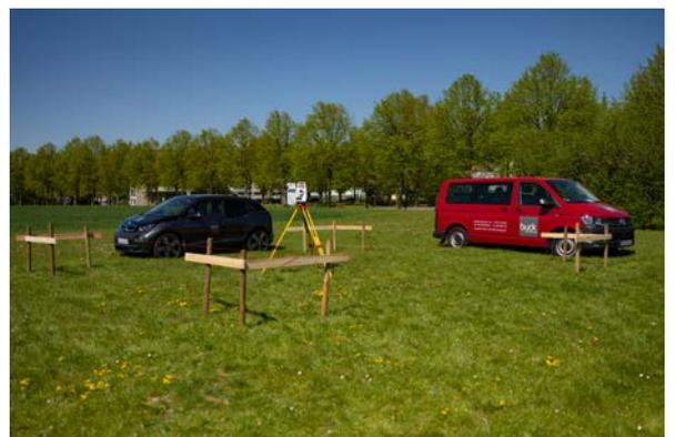
10. Eine um die Nägel gespannte Schnur markiert in den Schnitten die Hausecken. Auf Wunsch kann auch das Schnurgerüst auf eine vorgegebene Höhe gesetzt werden oder eine Höhenmarkierung am Schnurgerüst vorgenommen werden.
