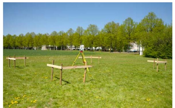
**4.** Die Pflöcke sollten lotrecht stehen. **5.** An den Pflöcken wird in Höhe von ca. 50 cm über der geplanten Oberkante des Unterbaus bzw. des Fundamentes eine Markierung angebracht. **6.** Die Bretteroberkante soll mit der Markierung an den Pflöcken abschließen. **7.** Die Bretter müssen waagrecht auf gleicher Höhe angebracht werden. **8.** Die Schnurböcke müssen für jede Hausecke analog hergerichtet werden.
