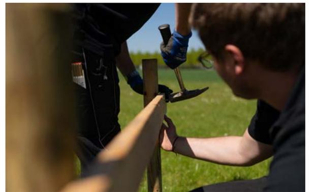
**1.** Zuerst muss die Position des Hauses bestimmt werden. Die ungefähren Standpunkte kann man z. B. mit Sand kennzeichnen um die Ausrichtung und die Abstände zu überprüfen. **2.** Anschließend werden in einem Abstand von 100 cm zu den Ecken die ersten 3 Pflöcke eingeschlagen. Diese sollten ca. 50 cm in den Boden geschlagen werden (etwas Anspitzen hilft). **3.** Danach werden die weiteren Pflöcke ungefähr parallel zu den Seiten des Hauses eingeschlagen.
